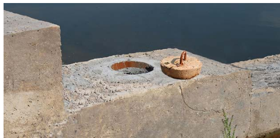
2013 年，芮源水库重新改建的涵管。
