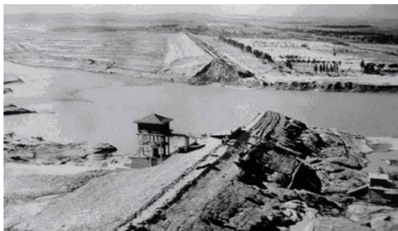
1975 年河南大水灾，国家建造的板桥大型水库发生了溃坝。
