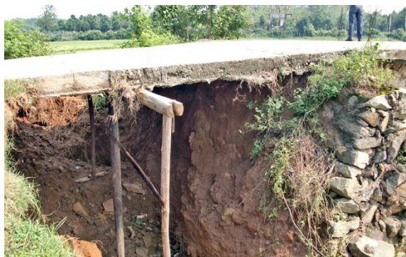
2010年江西水灾，进入里陂上村的唯一通路上的桥梁，大水过后成了危桥（水泥板中甚至没有钢筋）。
